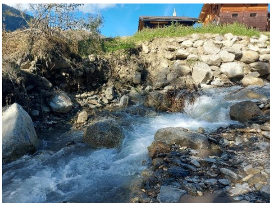
Schäden im Bereich der Wasserfassung vom Gewerbekanal nach Hochwasser vom August 2023
