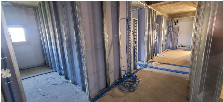
Beplankung und Verlegen von Leitungen vor Installation der neuen Bodenheizung
