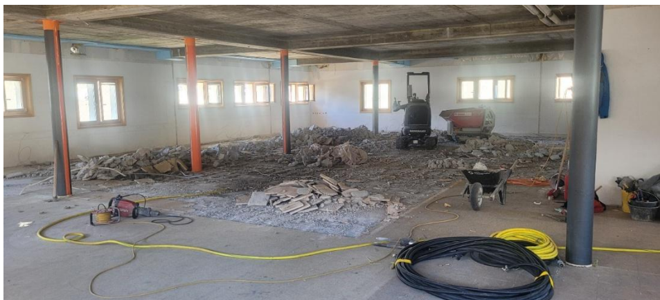
Abbruch der Bodenplatten und der Bodenheizung
